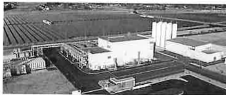
福島水素エネルギー研究フィールド
